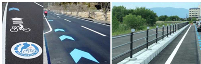
矢羽根による路面表示と案内整備、 走行空間整備（拡幅）
