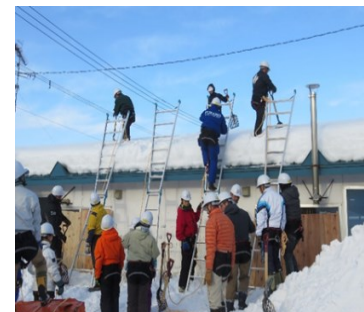
雪下ろし実技講習
