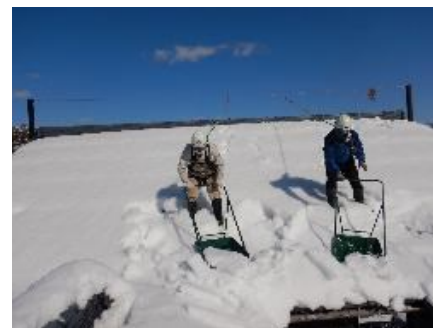
アンカーを活用した雪下ろし
