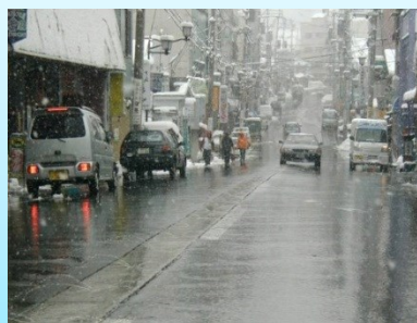
下水処理水を活用した消雪
