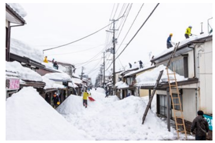
●住家の屋根形状や雪の質量等のデータから適切な雪下ろしのタイミングを判断
