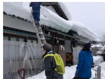
屋根雪下ろし作業の実施
