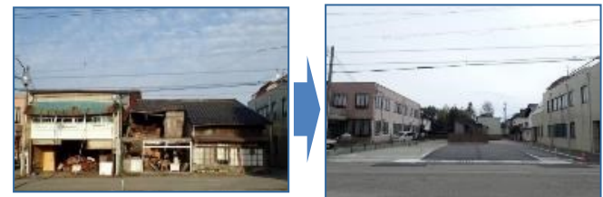
居住環境の整備改善のため、空き家を除却
