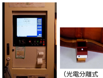
(R型受信機) (光電分離式煙感知器) 高性能な自動火災報知施設を設置し、迅速に初期消火へ
