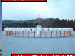
航空保安無線施設
