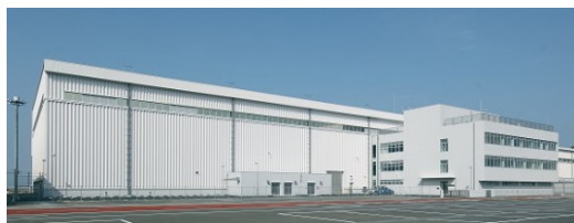
飛行検査センター庁舎・格納庫
