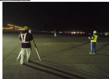
＜人力による水準測量状況＞
