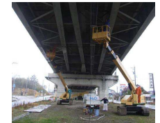
高所作業車による洗浄イメージ
