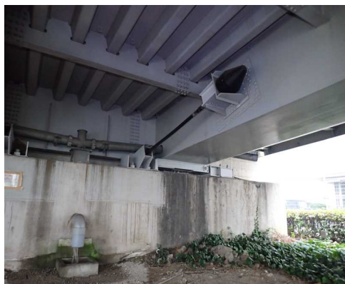
A1橋台 (始点側)
