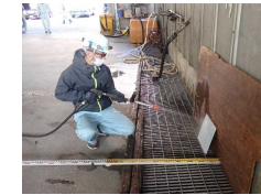
ヤード試験状況
