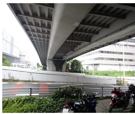
P1~P2径間 (中央径間)
