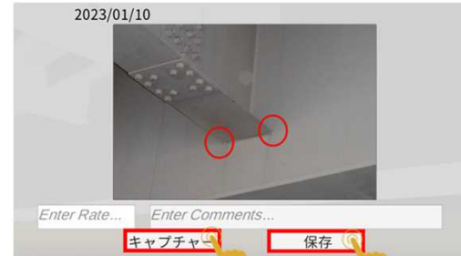
変状発生状況撮影結果の保存
