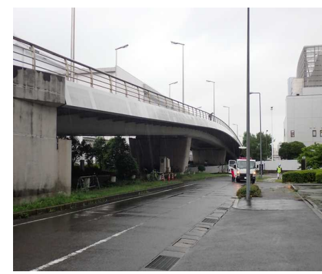
P2~A2径間 (終点側側径間)
