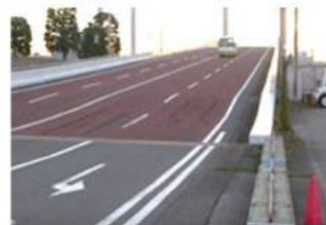
C エアサイド橋 《往復2.4km》
