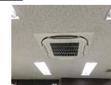
換気設備の導入
