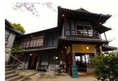
空き家群を面的に再生し活用（広島県尾道市）
