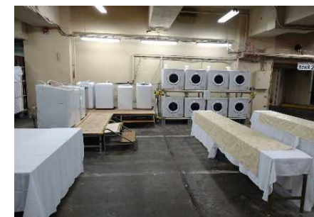
(地下駐車場の様子)
