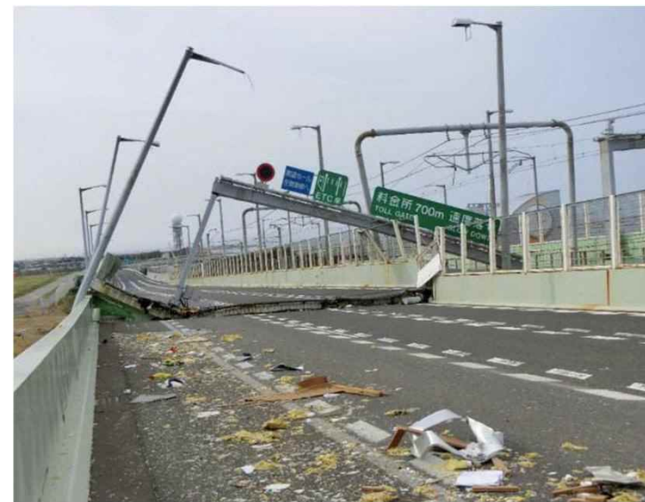
関西国際空港連絡橋の損傷状況
