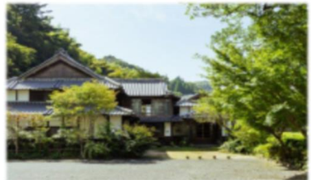
受入拠点の改修
