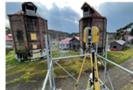
3Dレーザースキャナ による計測作業状況
