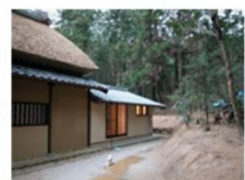
保存管理施設の設置
