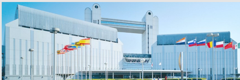
(対象施設の外観)
