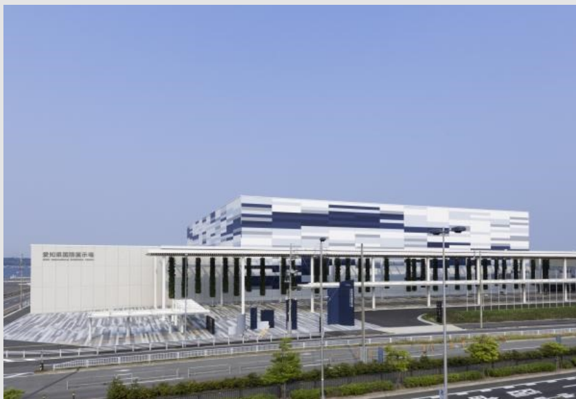
(対象施設の外観)
