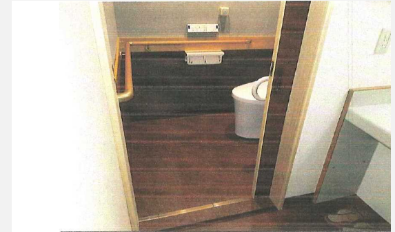
② 開口幅の拡大・引き戸の設置
