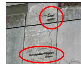
躯体(鉄筋)の爆裂
