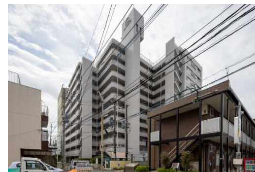
再建マンションの外観
