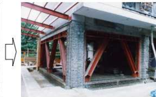
（工事中の写真）
