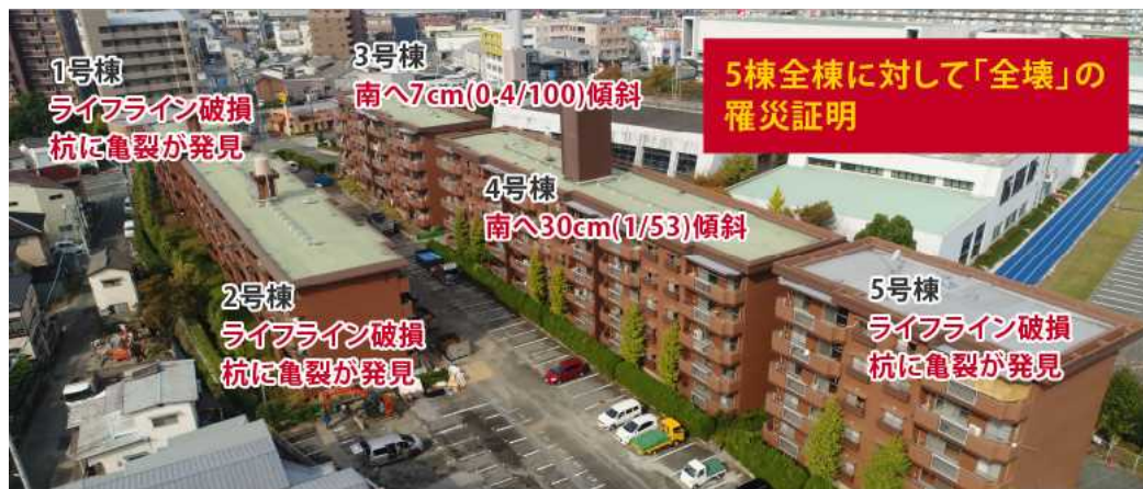
被災状況①
