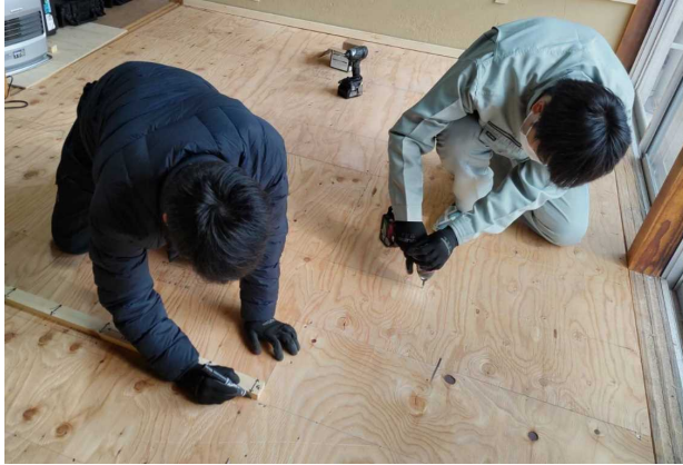
写真5 内部床のビス打ち
