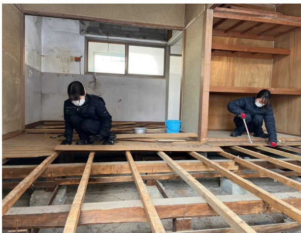
写真3 床板の撤去
