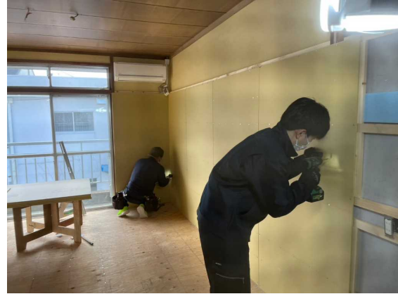
写真6 石膏ボードの取り付け
