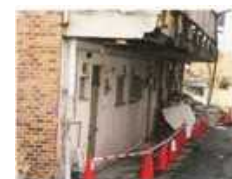
(建物の傷みが著しく外壁の剥落等が生じた事例)
