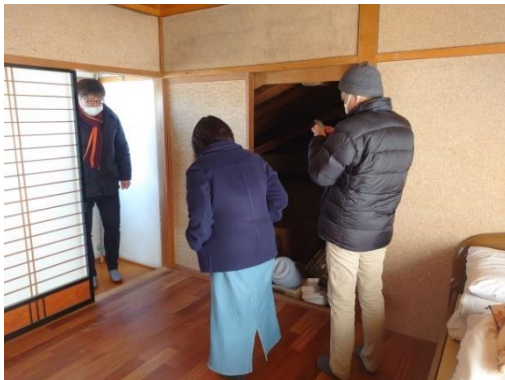
写真8 空き家内部の調査
