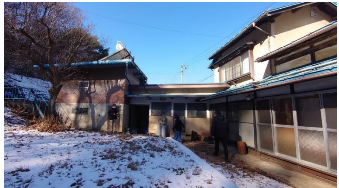
写真9 空き家の外観調査
