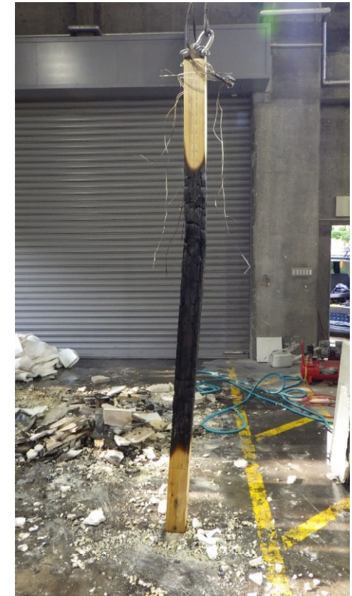
柱の座屈状況
