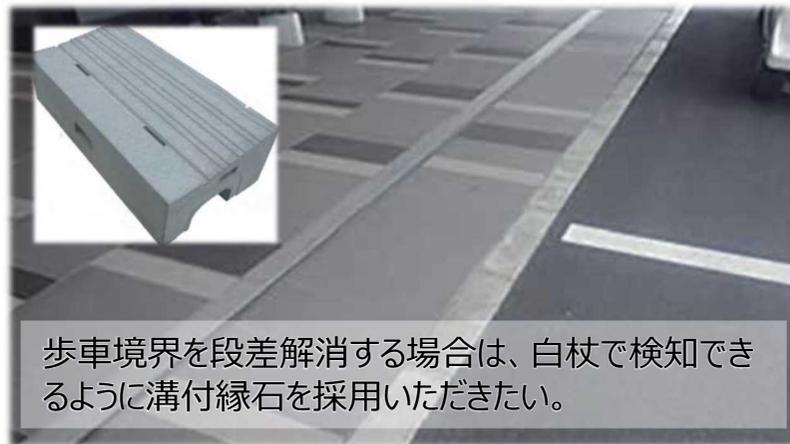
歩車境界を段差解消する場合は、白杖で検知できるように溝付縁石を採用いただきたい。
