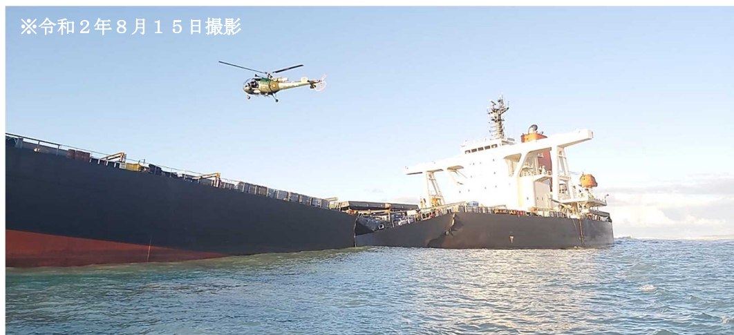
写真8 座屈を生じた船体
