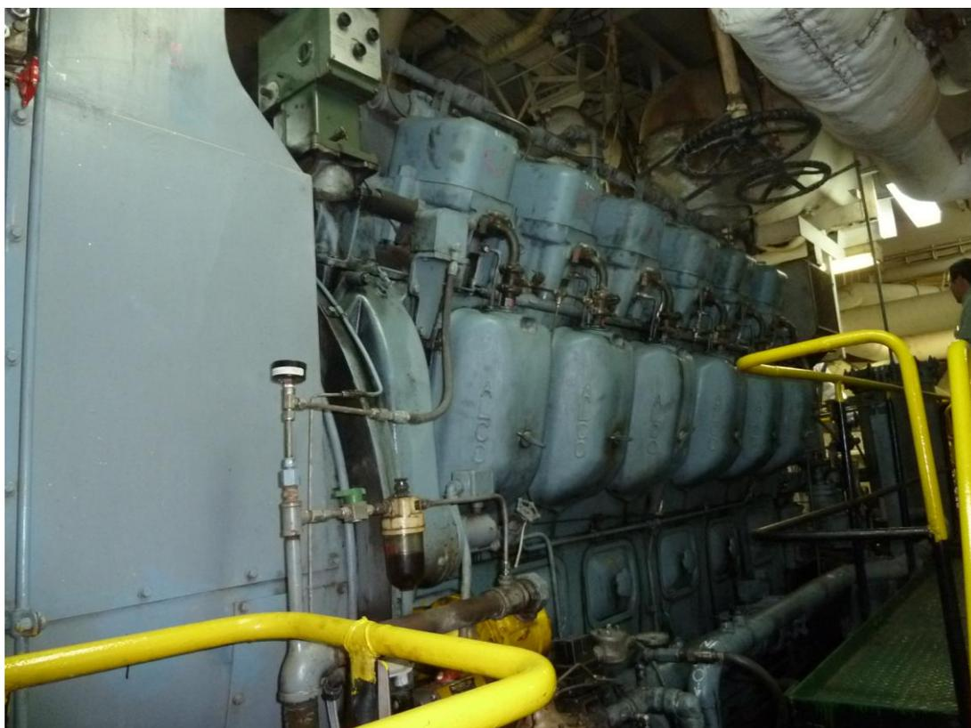
写真3 非常用ディーゼル発電機 (原動機)
