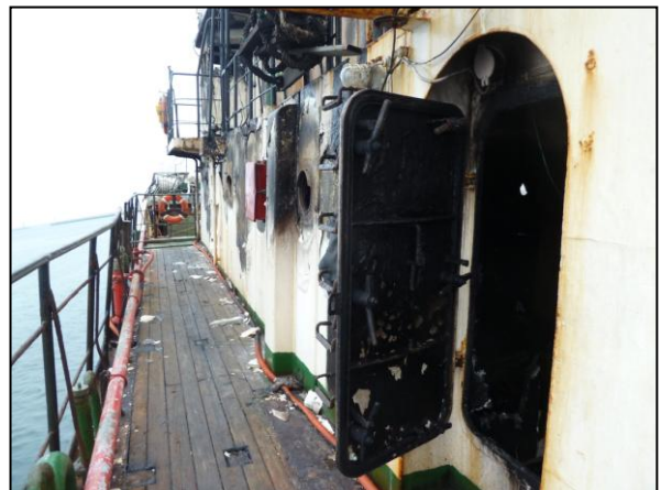
写真6 居住区左舷屋外通路
