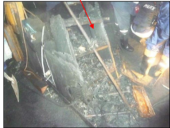
写真⑳ 冷凍機士ベッド船首方の木製階段
