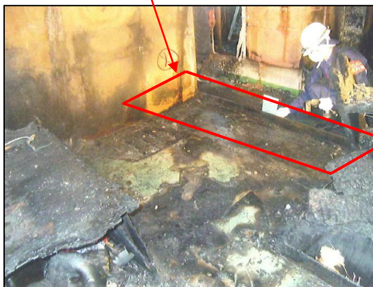
写真⑰ 冷凍機士のベッド周辺
