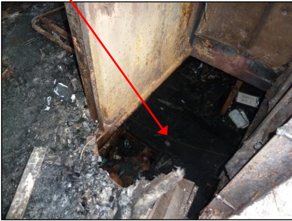
写真⑤ 海図室船尾方階段付近
