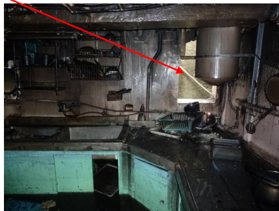
写真② 厨房外板開口部 (厨房内から撮影)
