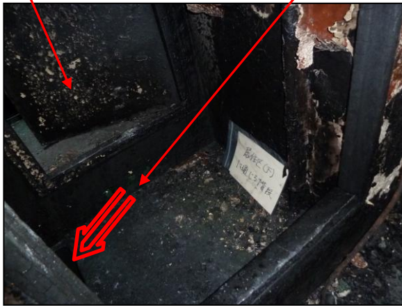
写真⑨ 機関室出入口ドアと上甲板への階段部分
