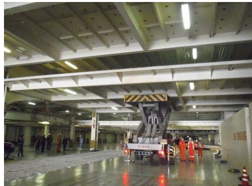
パネル作業の状況
