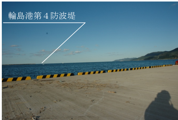
図 2.8-2 本件岸壁の状況
