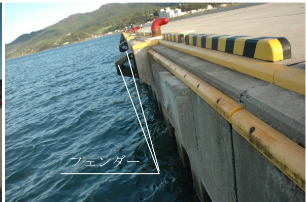
図 2.8-3 本件岸壁の状況
