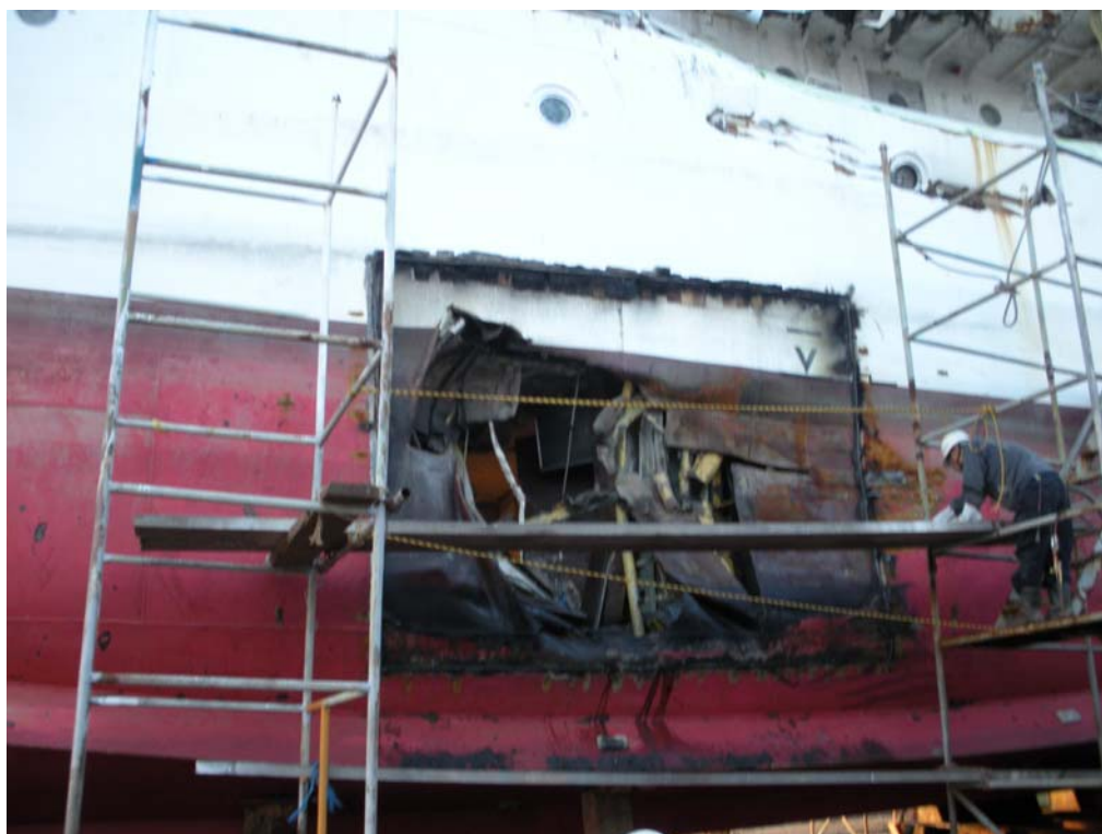
写真4 B船機関監視室損傷状況
