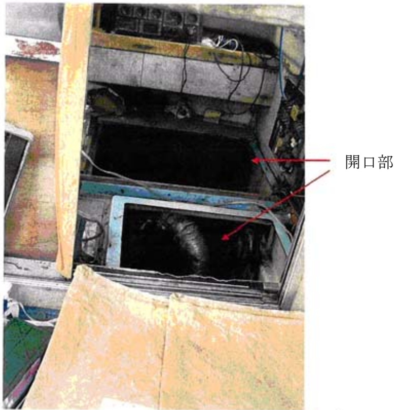
写真1 機関室上部の開口部
