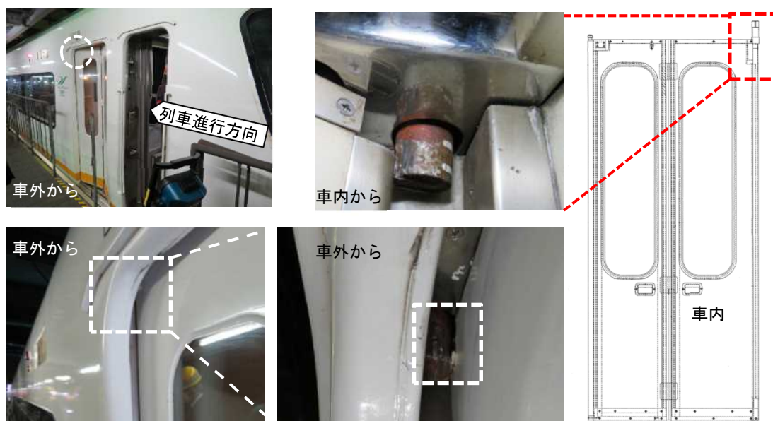
図6 本件扉の折戸上部の状態
