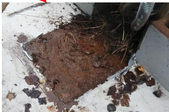
コンクリート躯体の表面の状況
