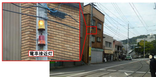
写真1 朝倉停留場・電車接近灯（伊野停留場方を撮影）
