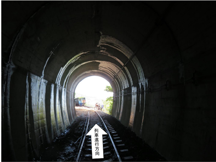
図3 本件トンネル内から見た列車進行方向の見通し状況 (土砂等から約30m手前)(事故翌日)
