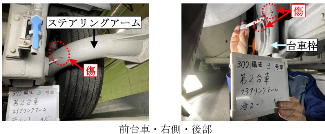
(d) 台車の損傷状況
