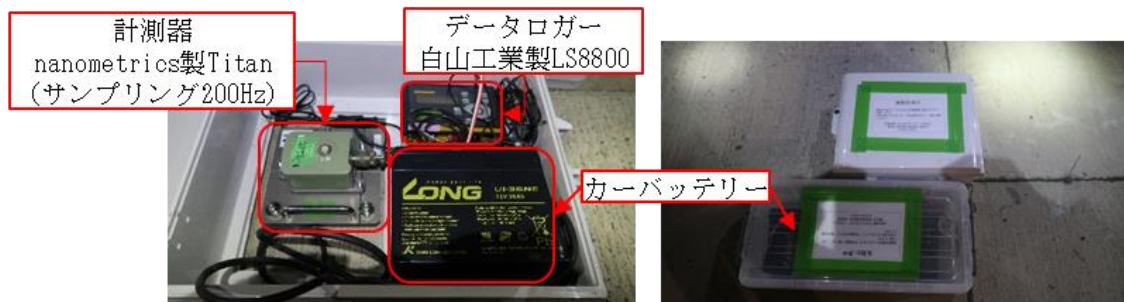
(e) 振動計の設置状況
