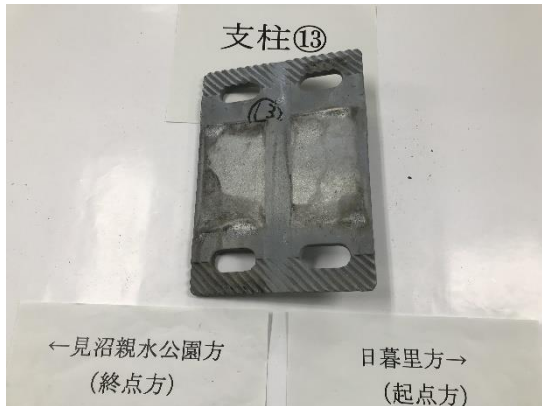
(a) 損傷なし (支柱⑬)
