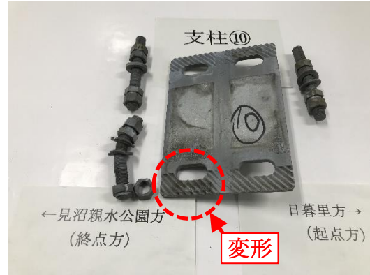
(b) 孔縁端部の変形 (支柱⑩)
