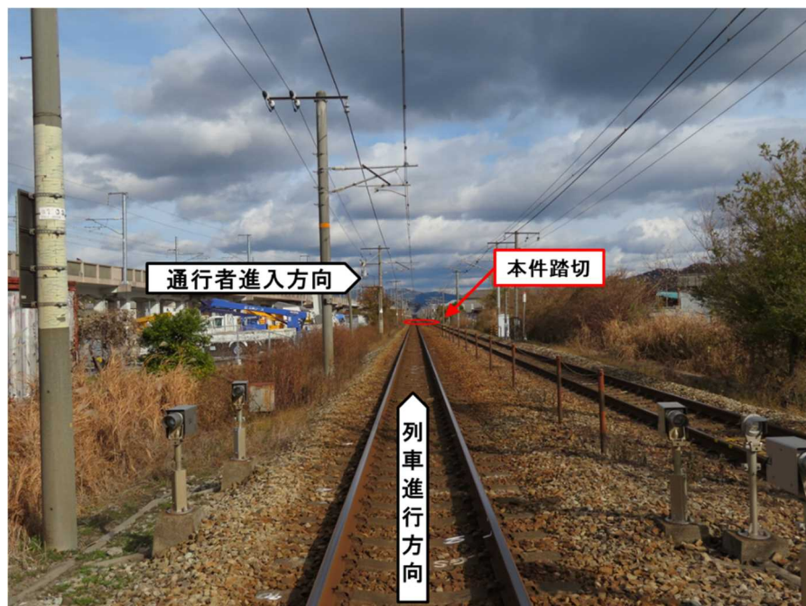
図4 本件列車側から見た本件踏切の見通し状況
