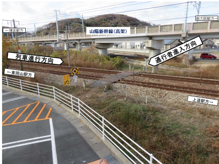
図3 本件踏切の状況（本件通行者進出側から撮影）
