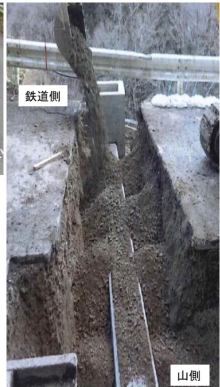
図9 新たに設置した水路
