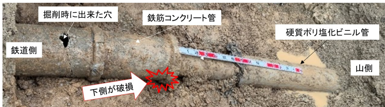
図6 道路下の水路の状況
