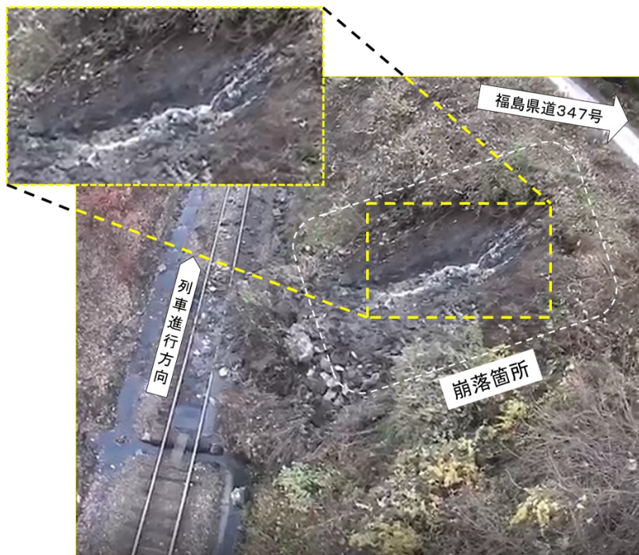
図2 崩壊した斜面
