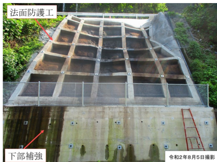
図10 法面防護工の実施状況
