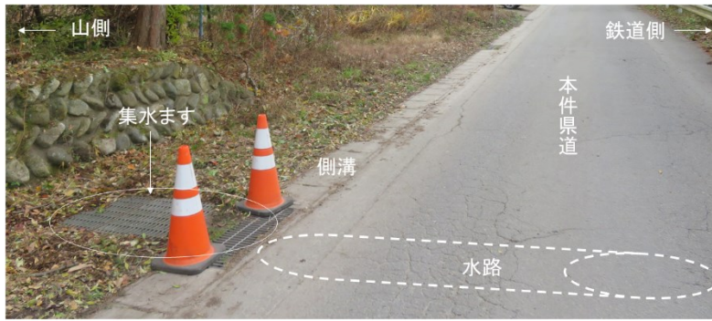
図8 事故当時の本件県道
