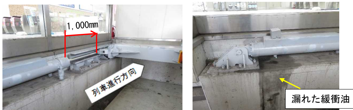
図3 事故後の油圧式緩衝装置の状態
