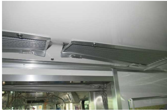
天井パネルのゆがみ （4両目の新杉田駅方）
