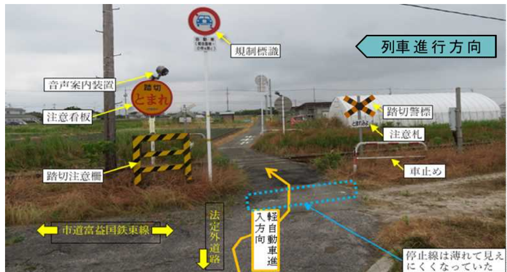
図3 本件踏切の状況 (本件軽自動車進入側から撮影)
