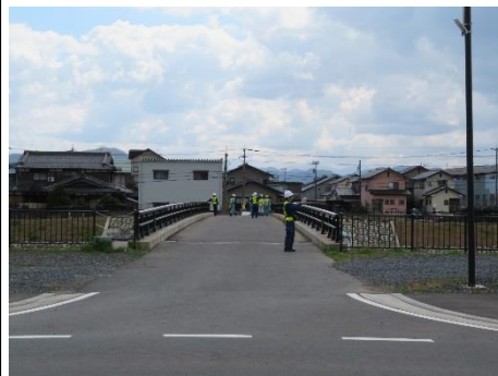
[a] 県道188号線と本件市道の交差点付近からの見通し
