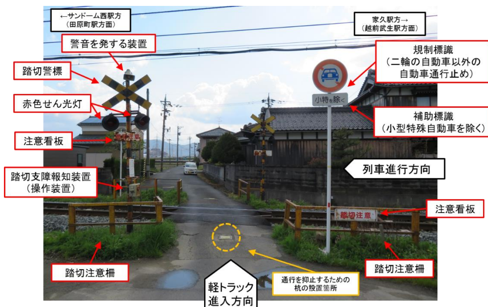
図2 軽トラック進入側から見た本件踏切の状況
