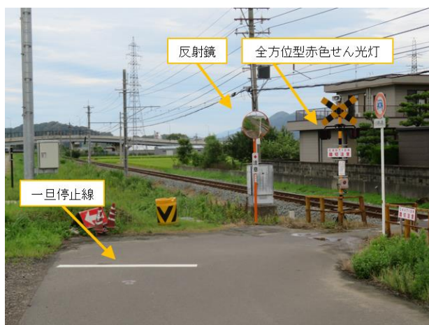
[a] 軽トラック進入側から見た本件踏切の状況
