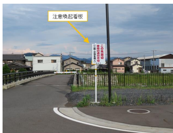
[b] 本件踏切に接続している本件市道入口の状況
