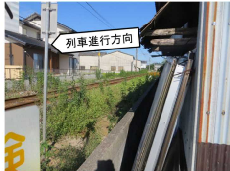
[b] ドットライン表示から見た状況
