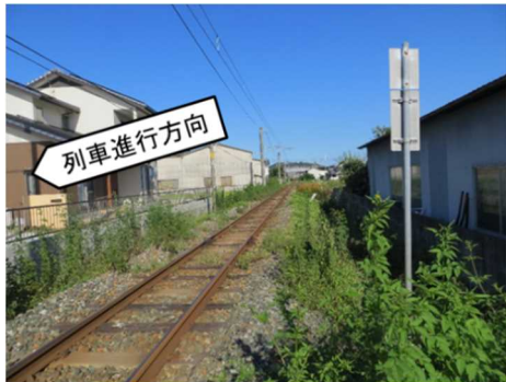
[a] 踏切注意柵から見た状況
