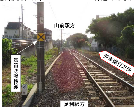
図9 本件踏切に対する気笛吹鳴標識
