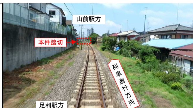
図8 本件列車側（上り列車）から見た本件踏切の見通し状況
