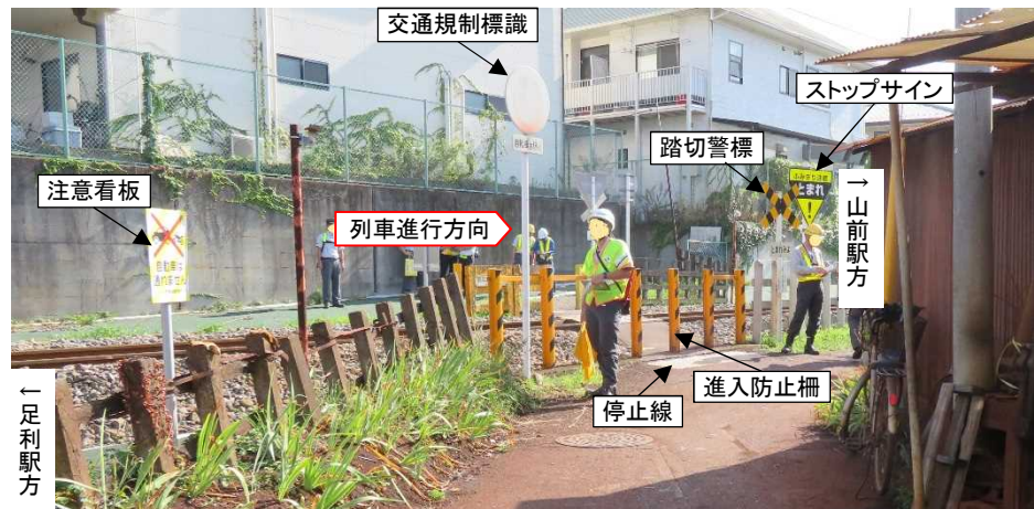
図3 本件踏切右側から見た本件踏切の状況
