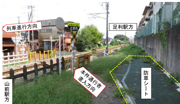
図4 本件踏切周辺の防草シート設置状況
