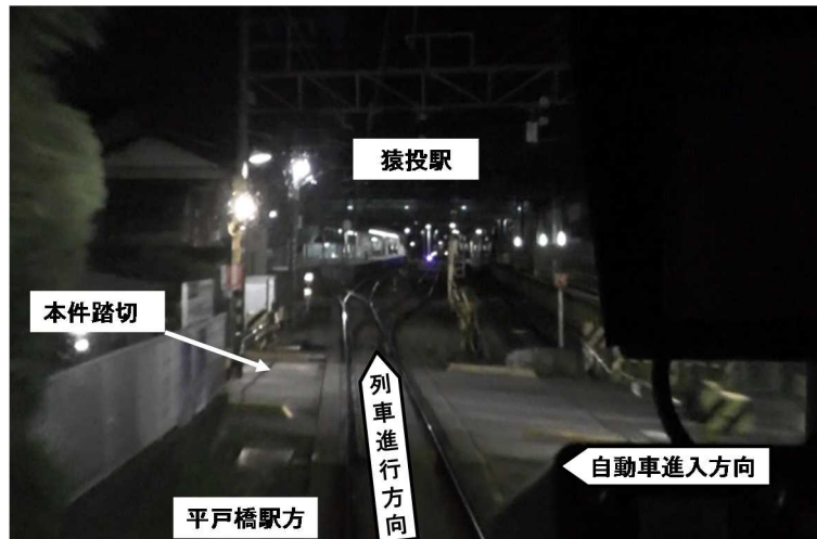
写真1 列車から見た本件踏切の見通し状況 (本件踏切から約10m手前)
