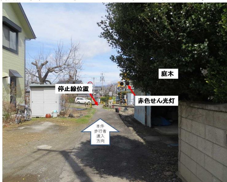
写真4 本件踏切の右側から進入する際の赤色せん光灯の見通し (停止線位置から約17mの位置)
