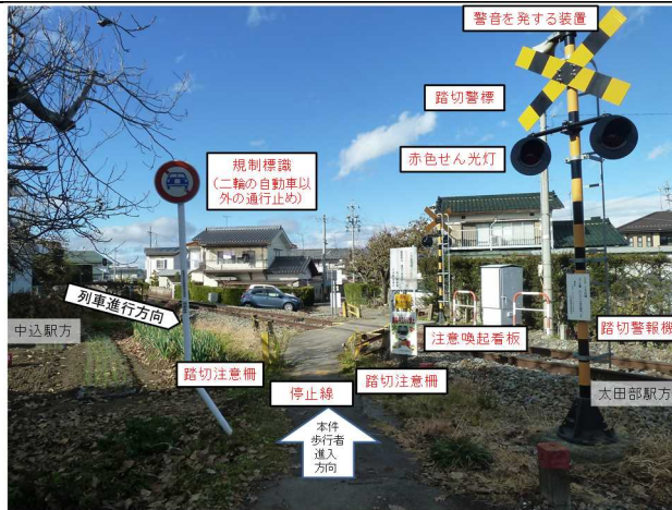
写真1 本件歩行者進入側から本件踏切を撮影
