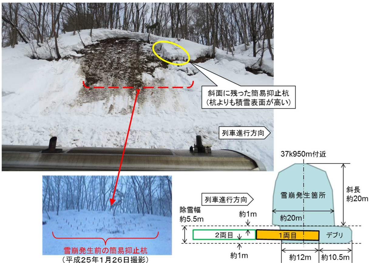
付図6 本件斜面の雪崩発生箇所
