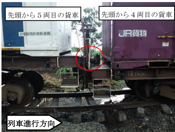
自動連結器のナックルが前位側の車体に乗っている状況
