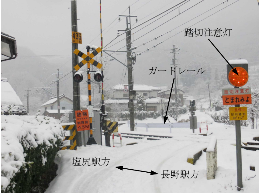
付図2 谷川踏切近傍の状況
