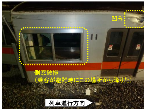
右側一番後ろ側窓破損、屋根上部に凹み
