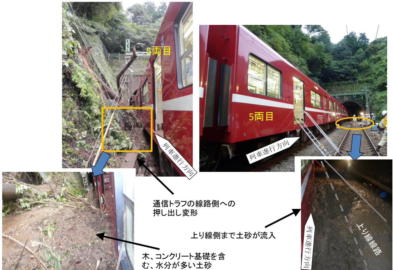
写真2 事故現場付近の状況（その2）
