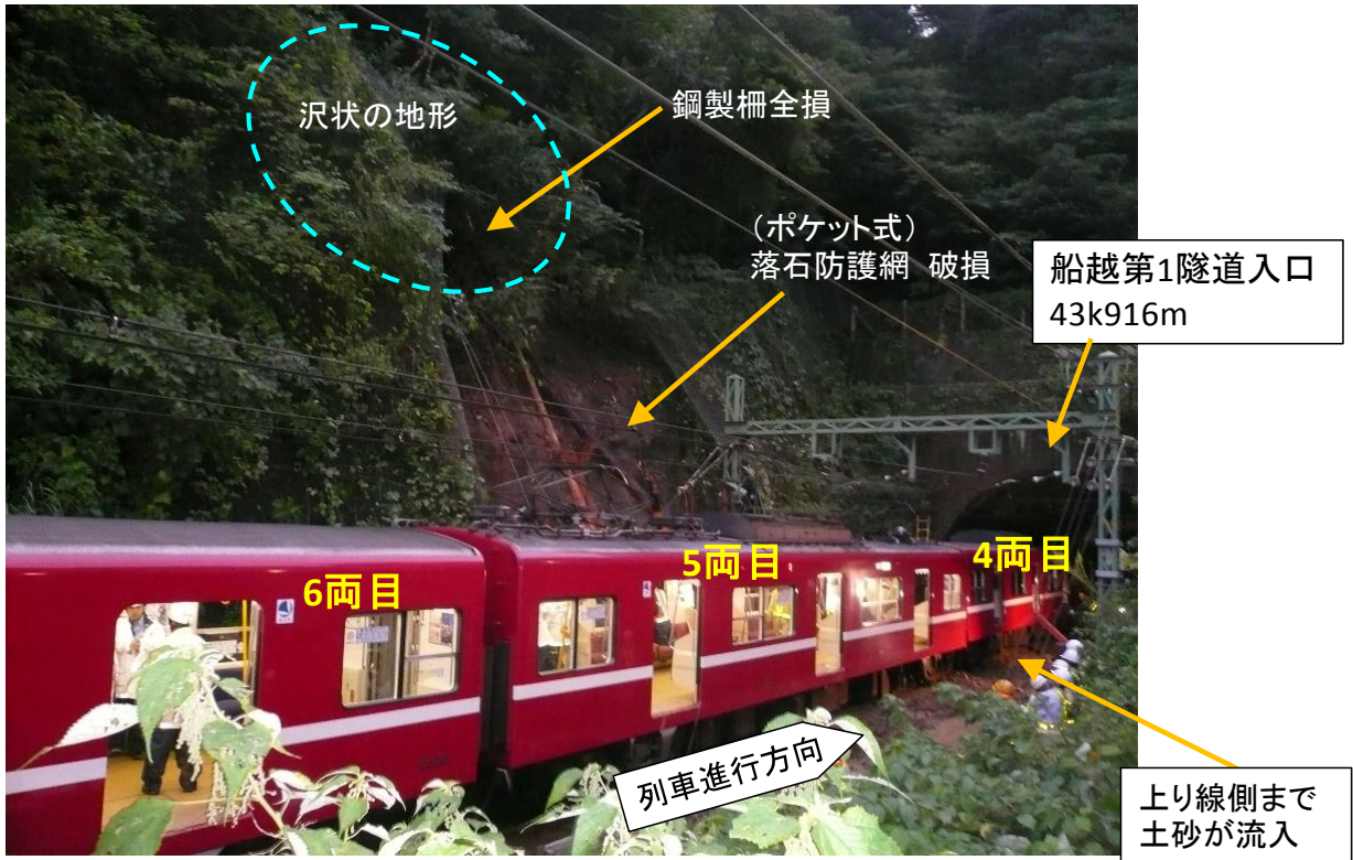
写真1 事故現場付近の状況（その1）
