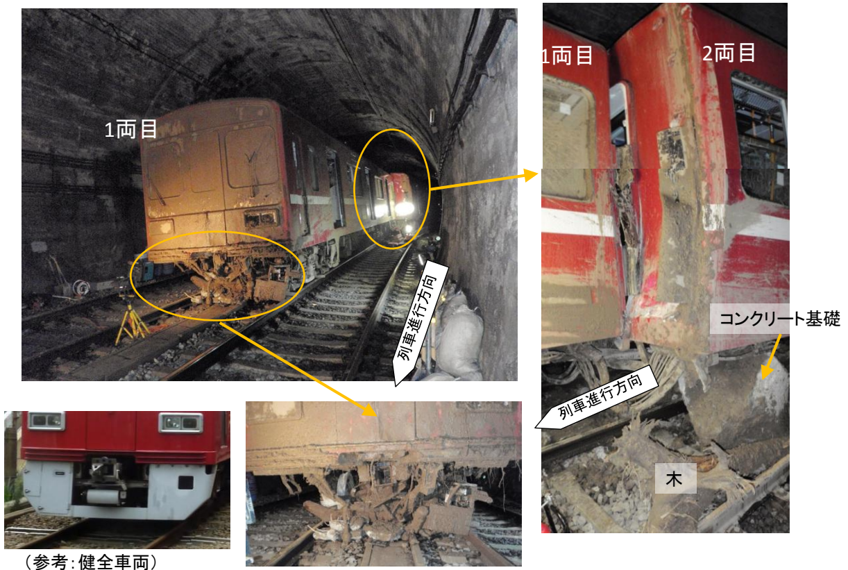
写真4 事故現場付近の状況（その4）
