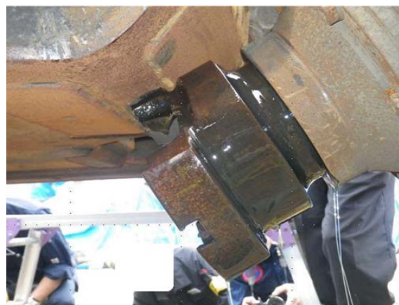
減速機側ヨークが台車枠下面に接触した状態
