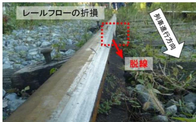
図4 レールフローが折損し軌間内脱線した例
