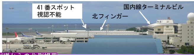
管制塔からの北側視界
