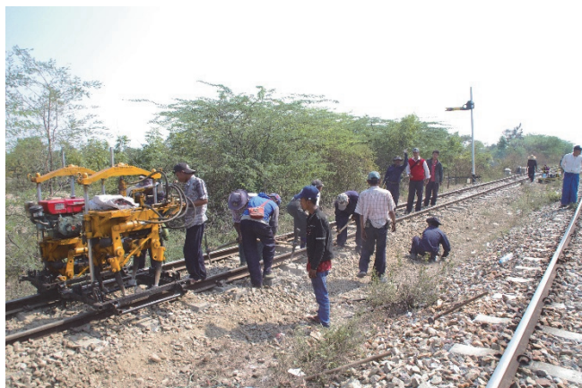
保線作業の様子
