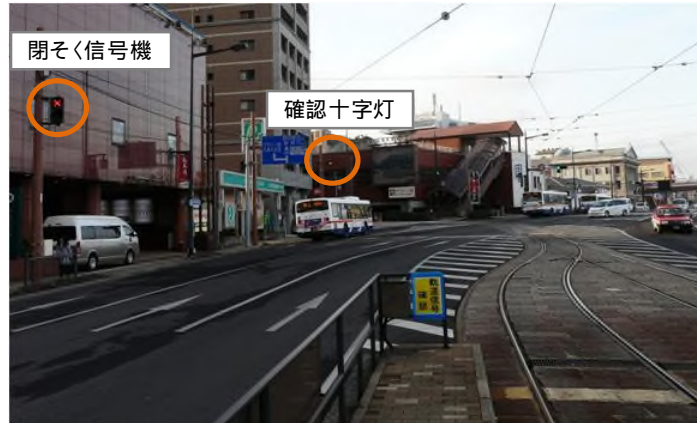
閉そく信号機の見通し状況
