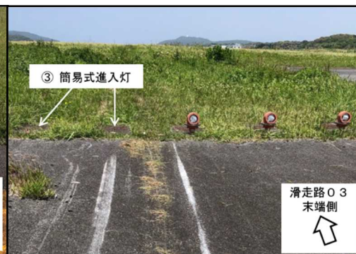
図4 地上施設の損壊状況
