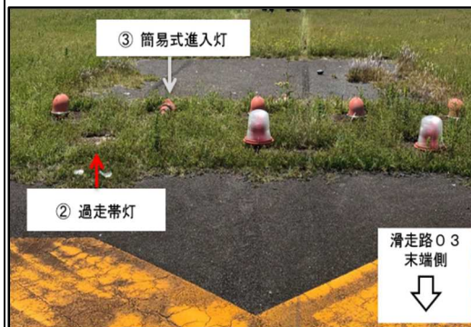
図4 地上施設の損壊状況
